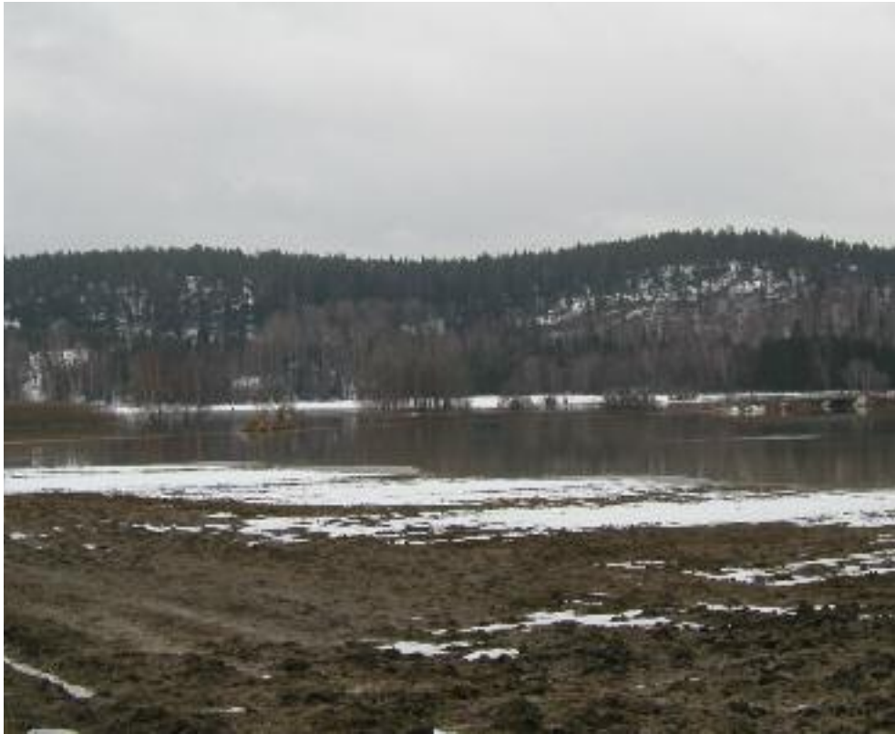
Så här var översvämningen på vägen och bron nedanför Berga-Tuna gård i april. Vägen var då avstängd för trafik. Foto Jan Gustafsson
